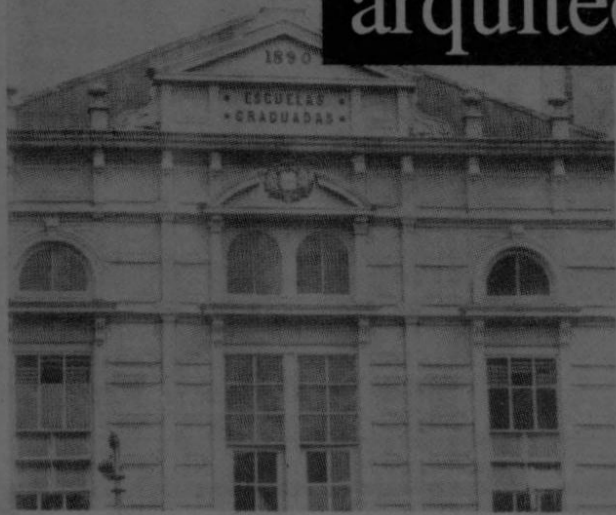
Escuela de varones, conocido como Edificio Metálico, construido en 1890.
